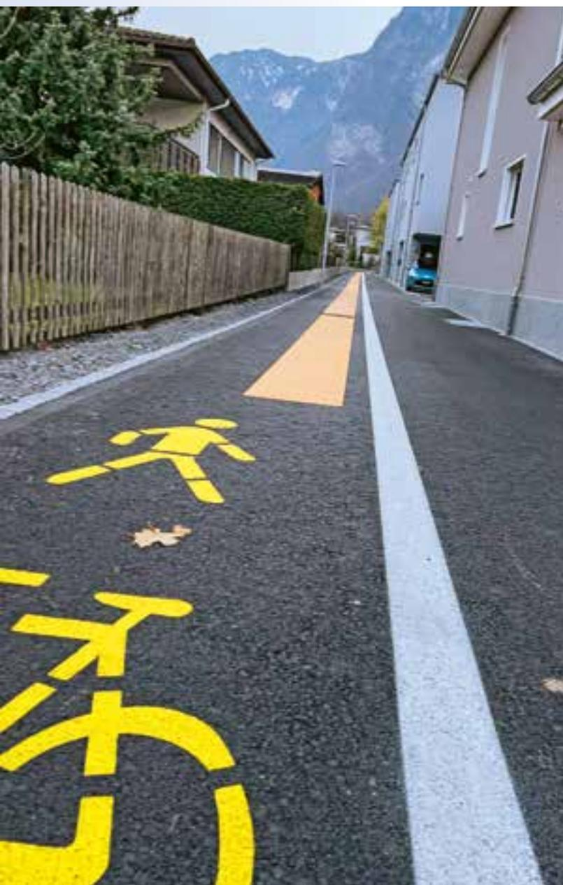
Auf der 110m langen Zufahrtstrasse für die Einfamilienhäuser wurde ein 1.50m breiter Korridor für den Fuss- und Radverkehr geschaffen. Die Bauarbeiten wurden im November 2022 mit den Markierungsarbeiten abgeschlossen.
