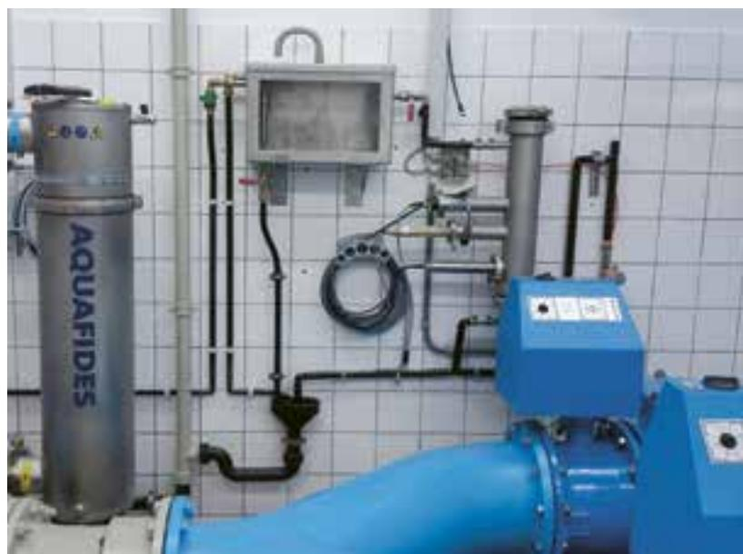
Wasseraufbereitung mittels UV-Entkeimung und Qualitätsüberwachungsstation
