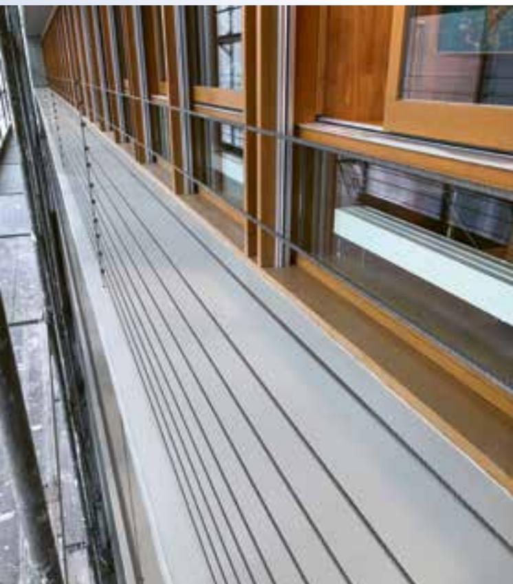
Um die Bausubstanz zu erhalten, drängte sich eine Sanierung der Balkonbeläge auf. Die Sanierung wurde während den Herbstferien der Schulen ausgeführt. Aufgrund der Wetterlage musste man das Gerüst vollständig mit Plastik einpacken und mit einer Warm- luftheizung konnte man die tiefen Temperaturen umgehen. Diese Massnahmen gewährleisteten eine hohe Qualität des neuen Belages.
