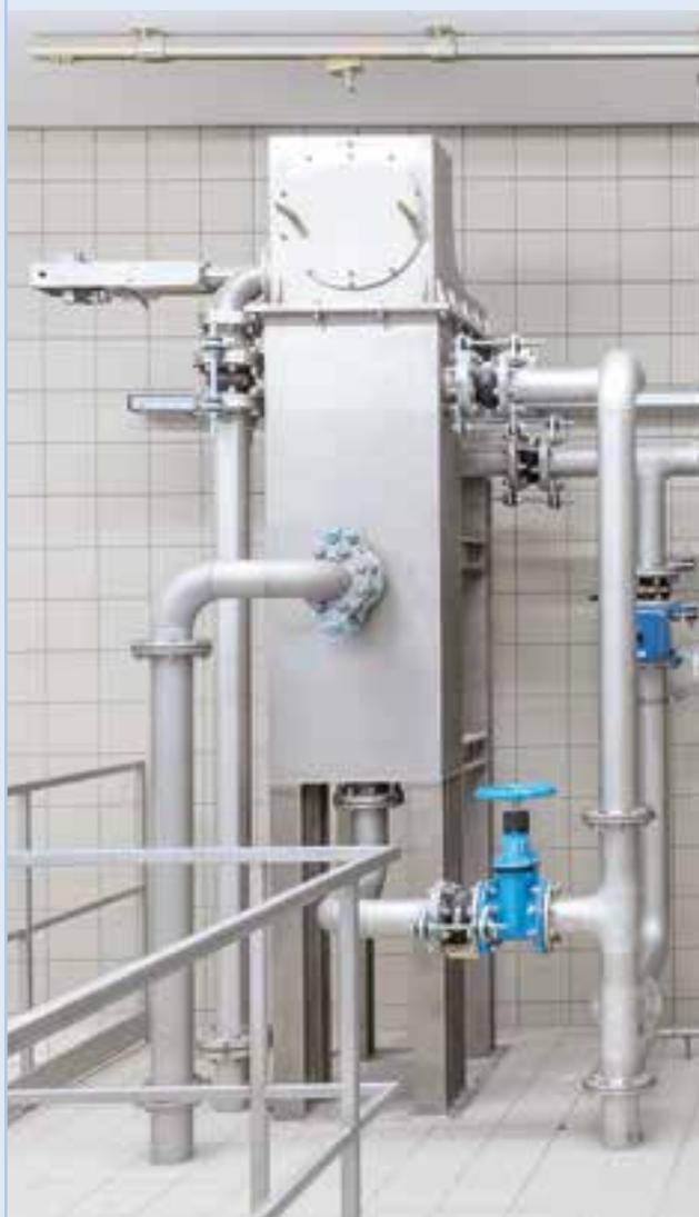
Im Zuge des Neubaus des Reservoirs Balzers-Wäldle im Jahr 2014 wurde auch der Bau eines kleinen Wasserkraftwerks ins Gesamtprojekt integriert. Das Kleinkraftwerk weist im Jahresdurchschnitt eine Leistung von 3.5 kW auf, was eine jährliche Energiemenge von rund 30'000 kWh ergibt. Mit dieser vom Wasser produzierten Energie können zehn durchschnittliche Haushalte versorgt werden, ehe das Wasser als Trinkwasser seiner weiteren Bestimmung zukommt.
