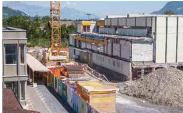
Nachdem die Schadstoffsanierung der Gebäudehülle grösstenteils abgeschlossen ist, wurde nach Ostern der Zwischentrakt zwischen der Turnhalle und dem Schulhaus Gnetsch abgerissen. Hier entsteht ein neuer Eingangstrakt mit einer behindertengerechten Erschliessung der Turnhalle und des Schwimmbades. Parallel zum Neubau des Zwischentraktes haben im Spätsommer die Arbeiten an den grossen Fassadenflächen der Turnhalle begonnen.
