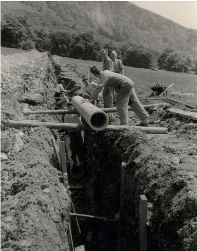
Bild 17: Bau Trinkwasserleitung auf Balzner Allmeind (u. a. stehend hinten rechts Bauführer Philipp Hasler, stehend Mitte Adolf Vogt, vorne Fredy Vogt)
