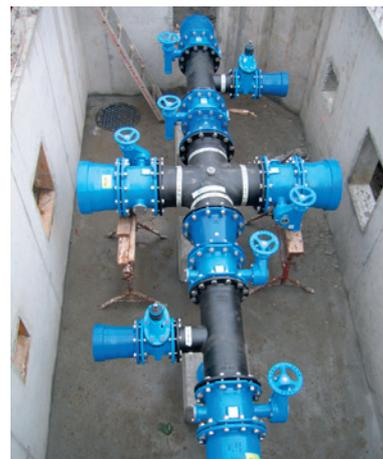
Bild 34: Einbau Klappenkombi in der Landstrasse Schacht Stabag, 2009
