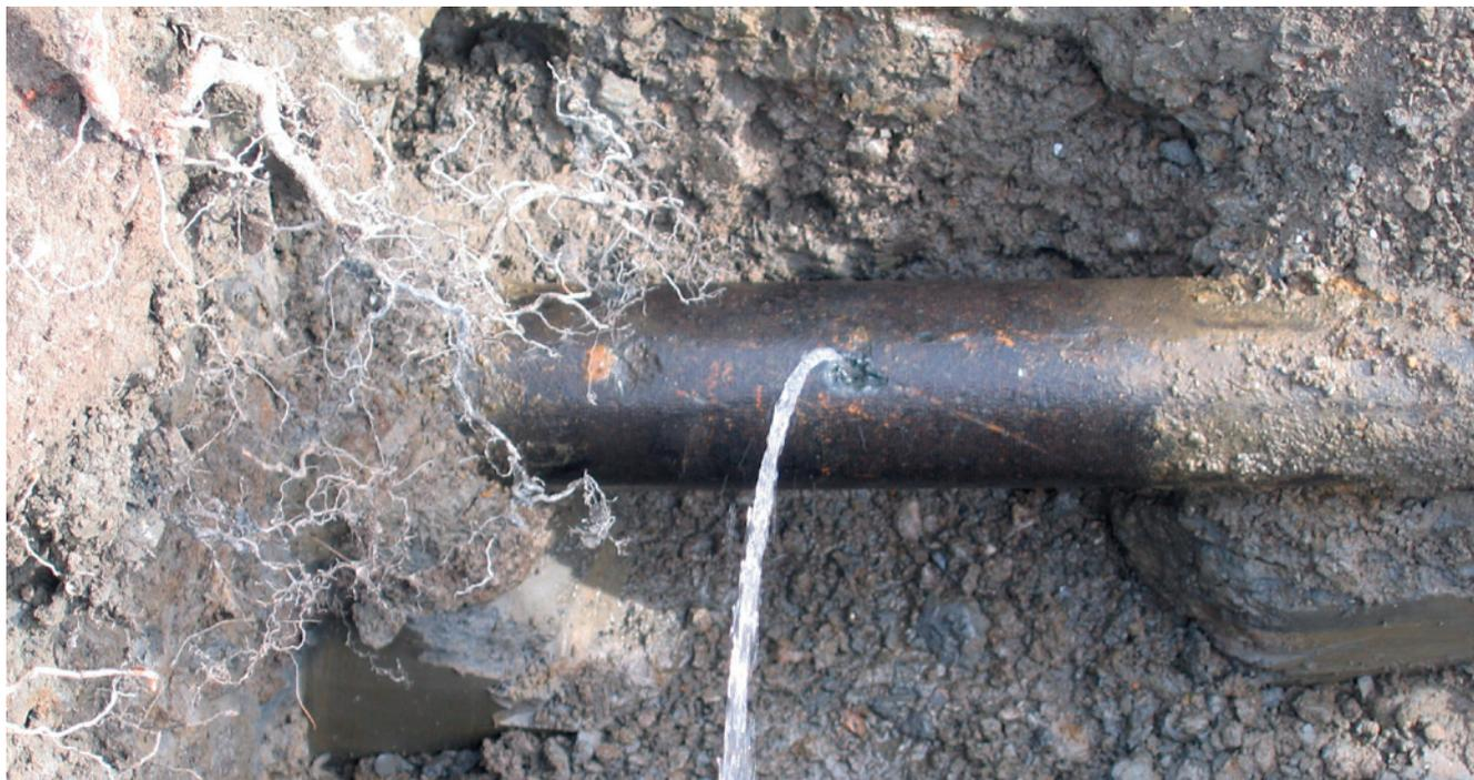
Bild 21: Rohrbruch (Bei einem 5 mm Loch entweichen ca. 45 m<sup>3</sup> Trinkwasser pro Tag bzw. 16'500 m<sup>3</sup> pro Jahr)
